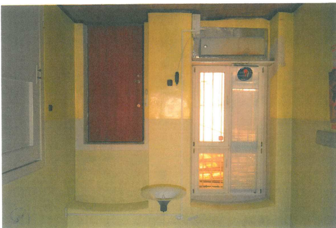
Fot. nr 5. Pomieszczenie główne. Część od strony podwórza. Wychście na klatkę schodową kamienicy i wyjście na zewnątrz.
