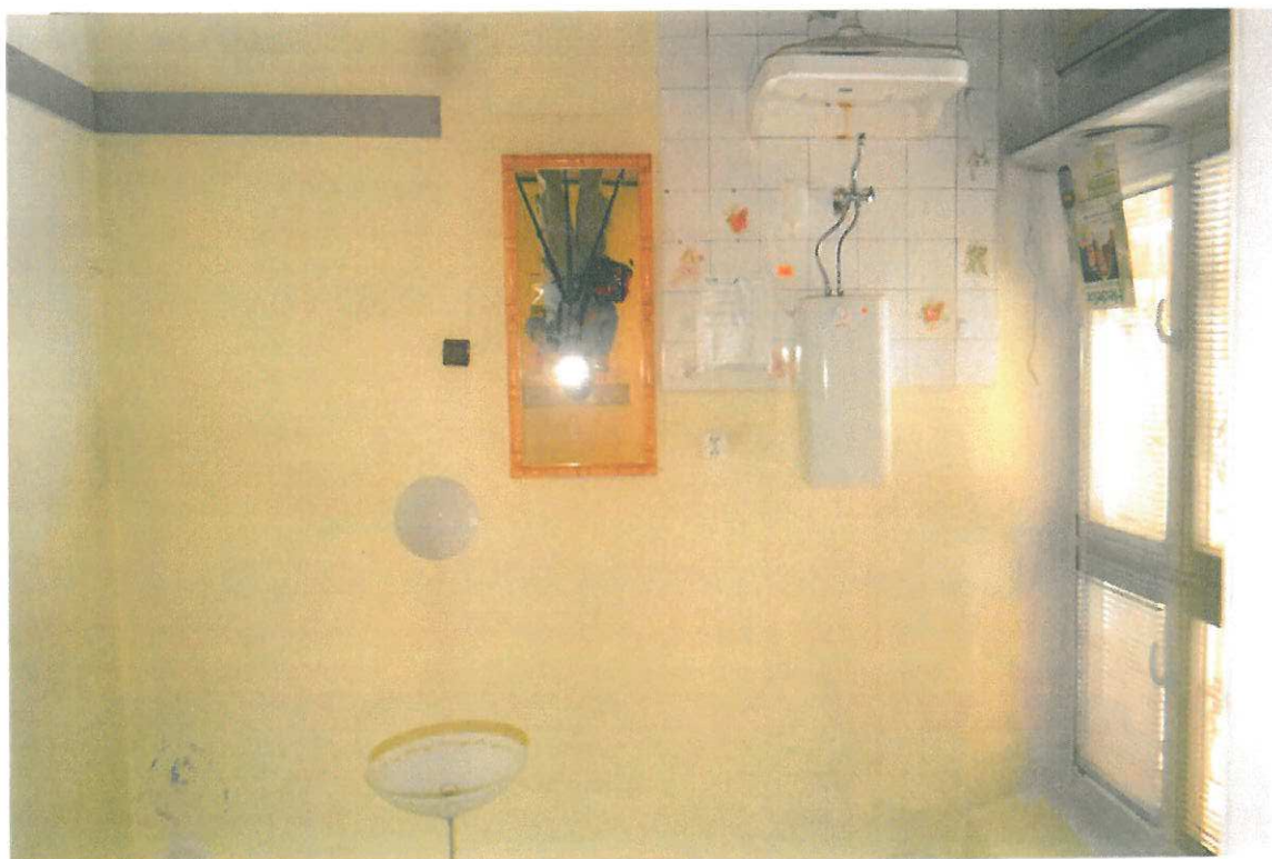
Fot. nr 7. Pomieszczenie sanitarne od strony podwórza.
