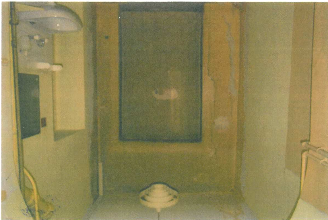
Fot. nr 8. Pomieszczenie sanitarne główne (WC) od strony podwórza.
