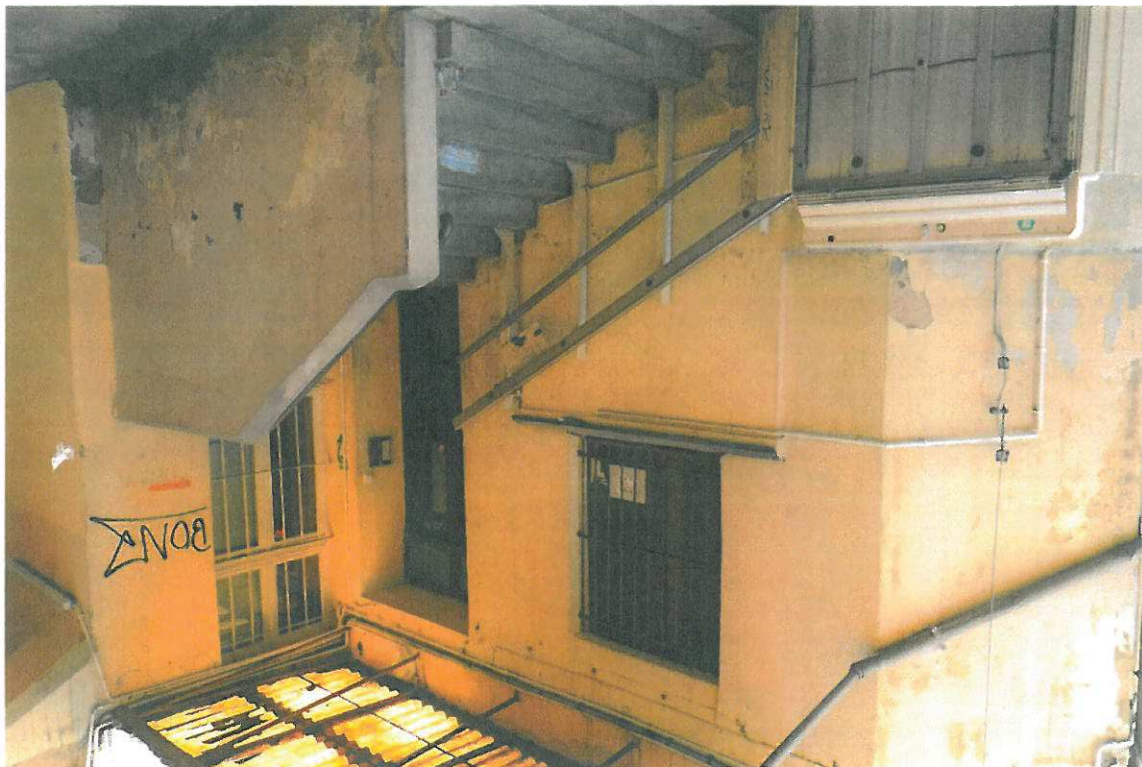
Fot. nr 10. Wylście do palacu Anderszów od strony podwórza. Wylście na klatkę schodową kamienicy; mieszkań i adaptowanego lokalu.
