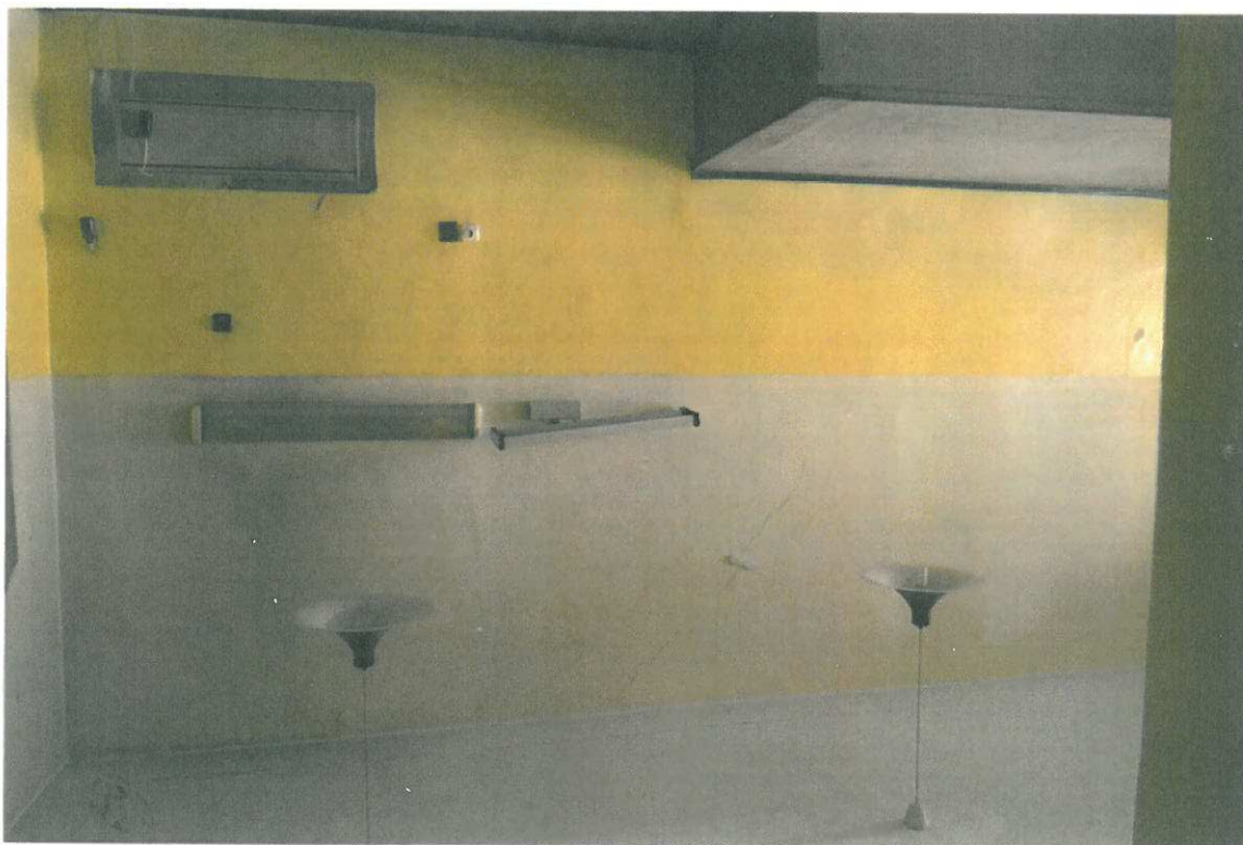
Fot. nr 6. Ściana boczna pom. głównego od strony bramy przejazdowej. U dołu obudowa zejścia do piwnicy z przejazdu.
