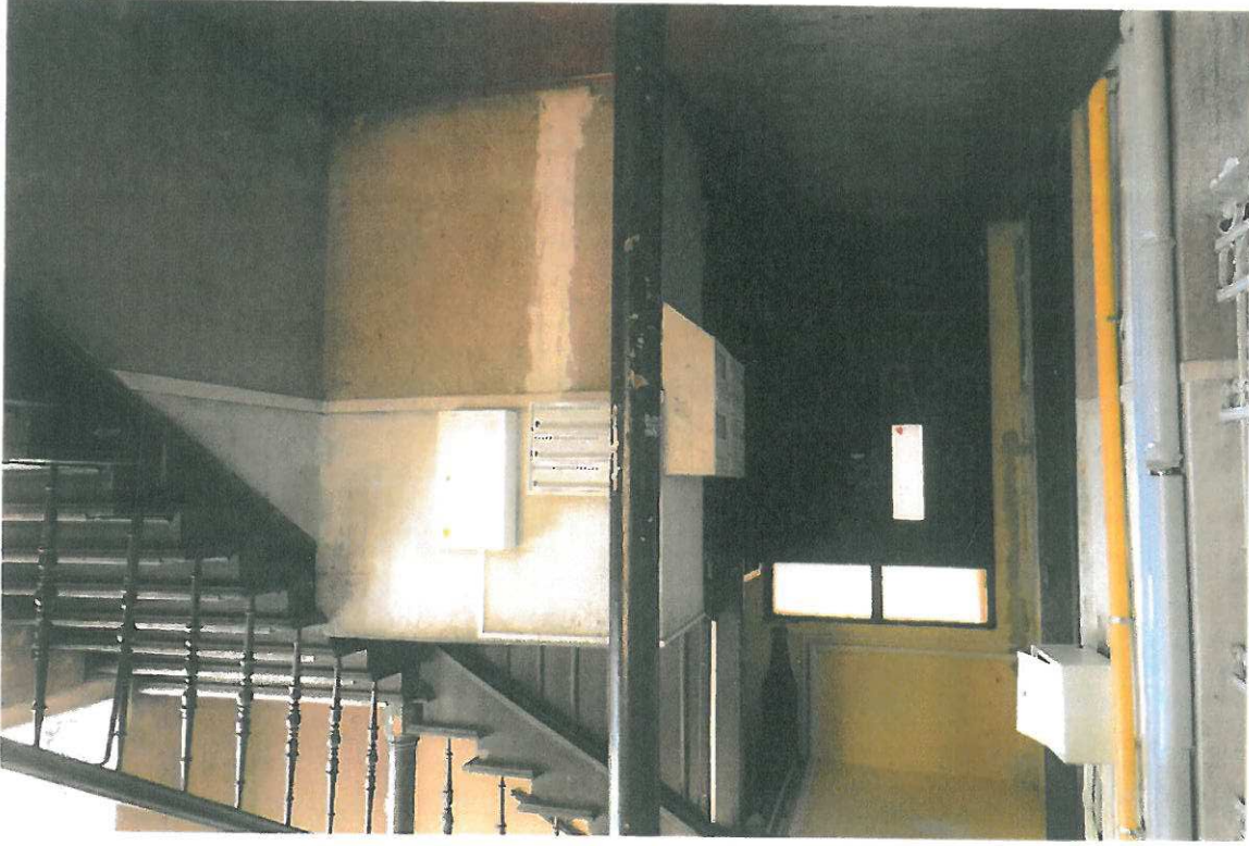
Fot. nr 14. Wylście na klatkę schodową, widok z klatki. Po prawej stronie zejście do piwnicy.
